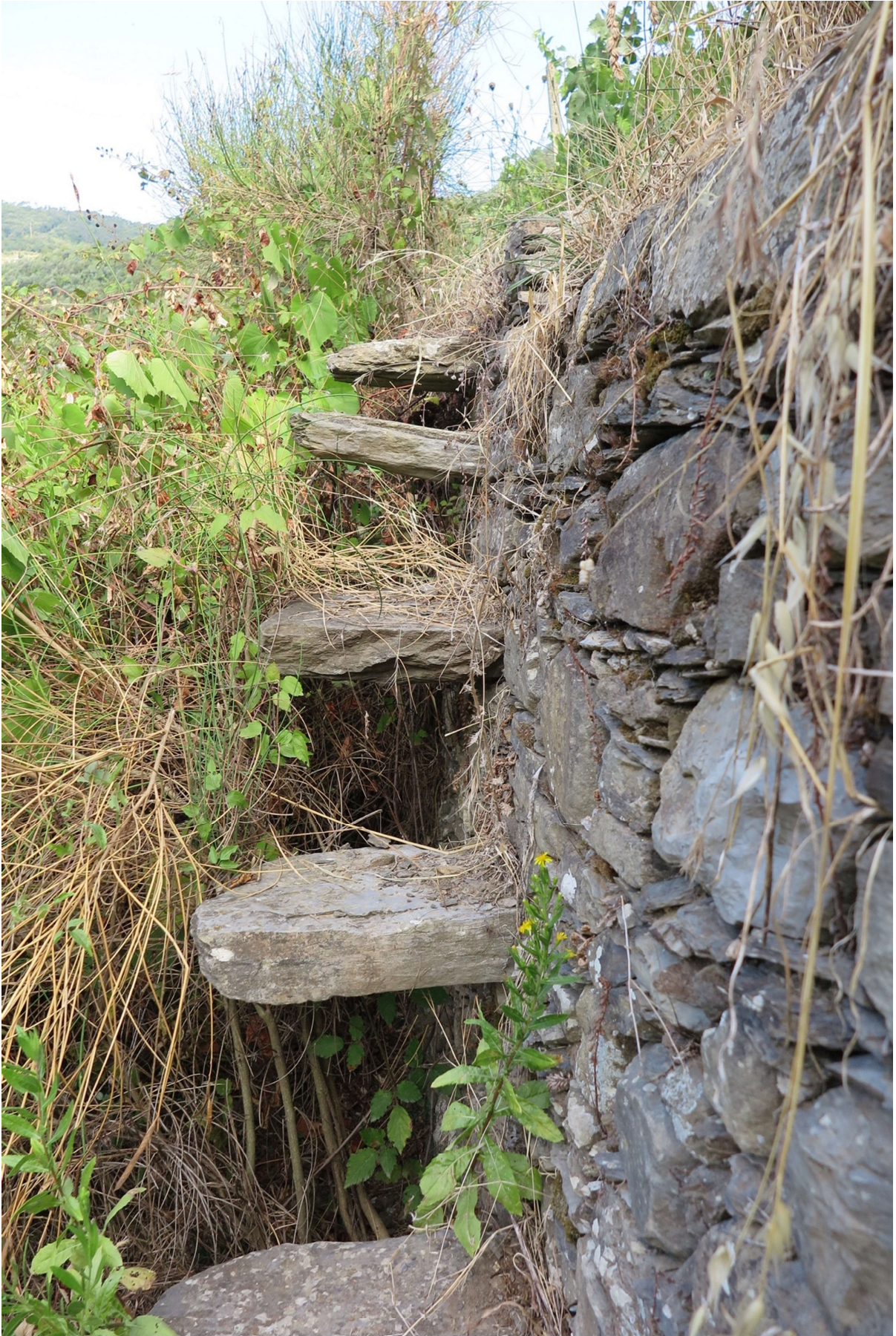
Una scaletta per il passaggio fra le fasce
