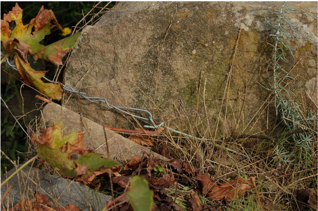
Ancoraggi a terra del pergolato in filo di rame per evitare la corrosione
