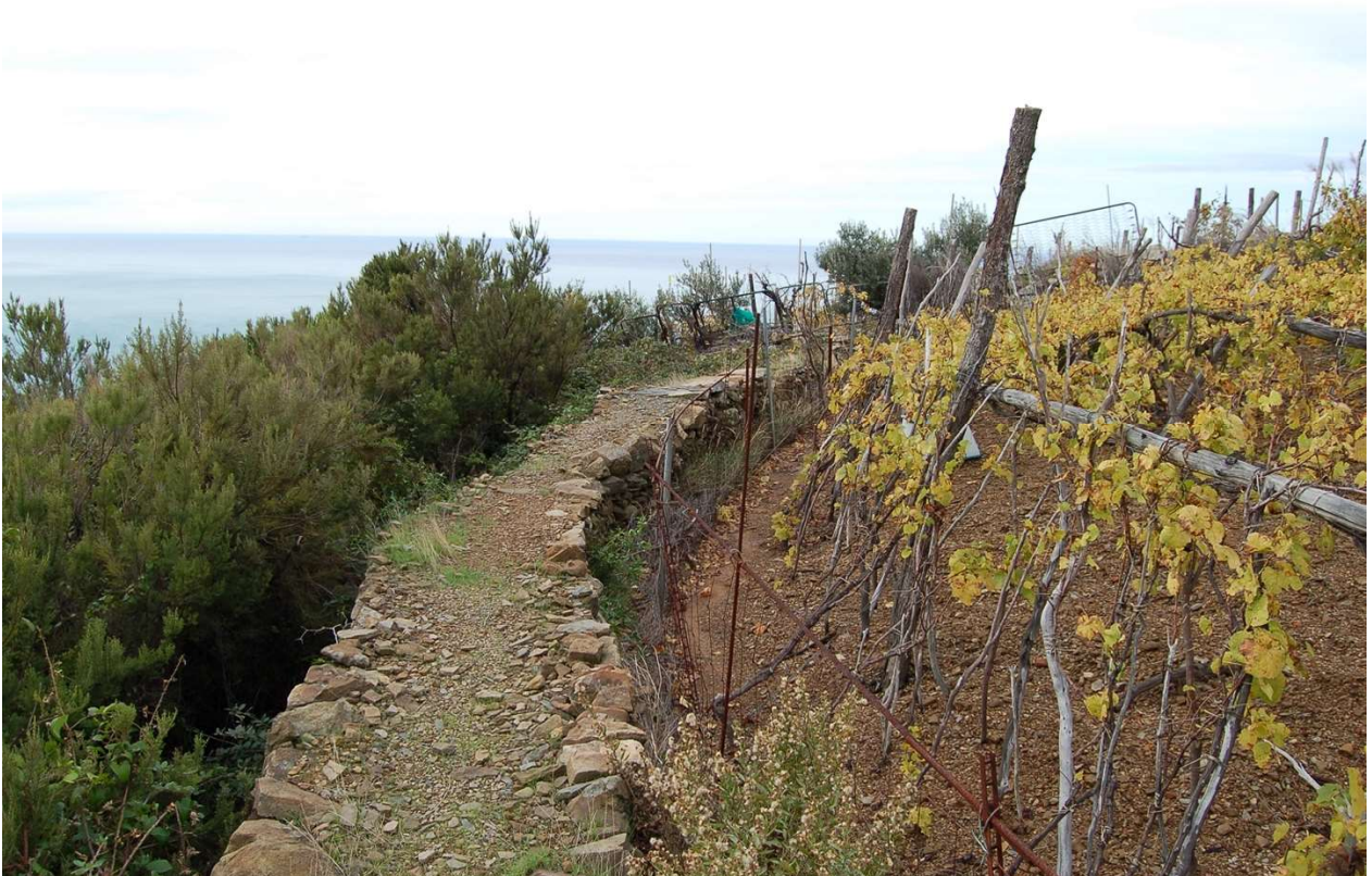
Muro di sostegno sopraelevato per frangivento
