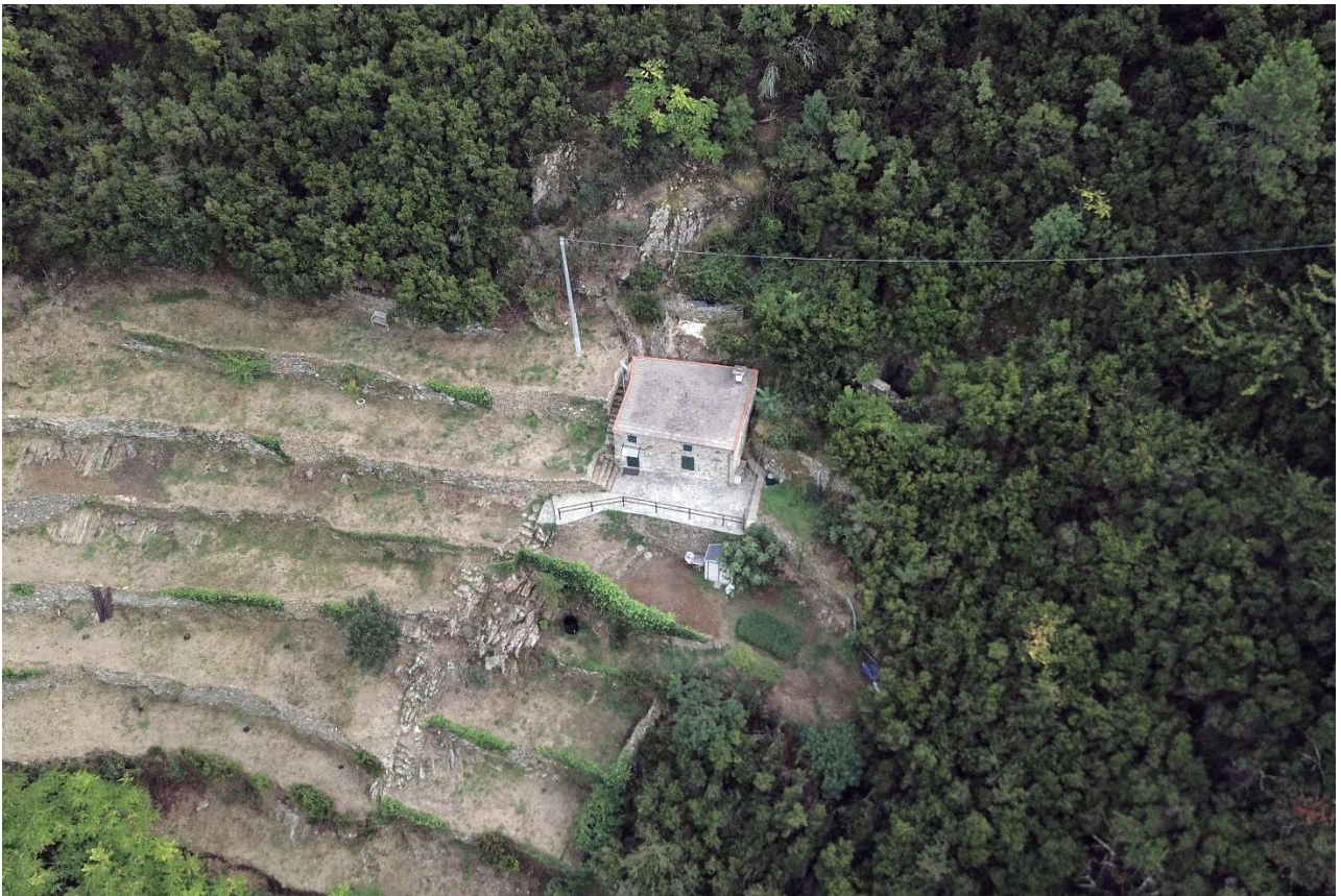
Un fabbricato rurale integrato ai terrazzamenti di pertinenza, da poco disboscati (09/ 2020)
